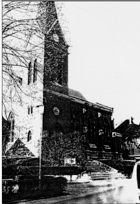
Abbildung 4: Im August 1976 wurde diese evangelischen Kirchen von D-96484 Meeder-Wiesefeld (oben) mit Zyklon B begast. Anschließend verfärbte sich der Putz überall fleckig blau (vgl. Abbildung 3).
