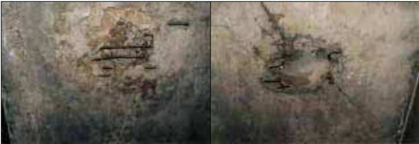
Abbildungen 24 und 25: Zerfallserscheinungen, sichtbar an der Innendecke des Leichenkellers des Krematorium I im Auschwitz-Stammlager: Nach über 50 Jahren fangen die nahe der Oberfläche liegenden Eisenbewehrung an zu rosten und sprengen den Beton auf. Die provisorischen Versuche der Museumsleitung, diese Löcher zu verputzen (rechts), sind zum Scheitern verurteilt.
