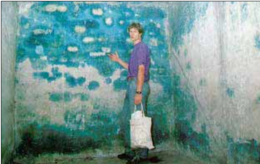
Abbildung 65: Aufnahme des nordwestlich gelegenen Innenraumes des Entwesungstraktes des Bauwerkes BW 5a (siehe Abbildung 18). Im Hintergrund und rechts im Bild die Außenmauer mit der intensiven Blaufärbung durch das Eisenblau. Die Probenentnahmestellen der Proben 9 und 11 sind zu erkennen. Links im Bild die Innenmauer, die mit dem Umbau zur Heißluftentwesungskammer eingezogen wurde. Von ihr wurde die Probe Nr. 10 genommen, mit leicht positivem Cyanid-Befund.
